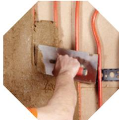
Die **isolierte Wandkonstruktion** hat einen U-Wert von nur 0,265 W/m<sup>2</sup>K. Zum Vergleich: Eine Außenwand aus Mauerziegeln (36,5 cm) kommt auf einen U-Wert von 0,8 W/m<sup>2</sup>K.
